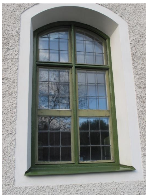
Arbetet har påbörjats, så karmarna är på dessa bilder målade. Bågarna är mycket anfrätta.
