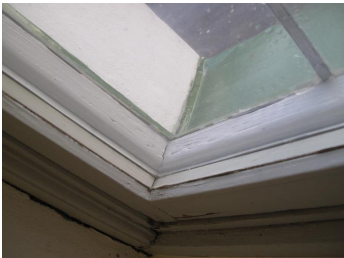
Fönster efter åtgärder. Ytterbågens insida har åtgärdats.
