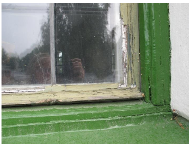
Arbetet har påbörjats, så karmarna är på dessa bilder målade. Bågarna är mycket anfrätta.
