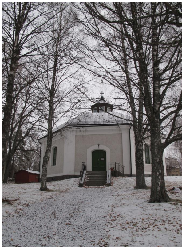
Vedevågs kyrka efter åtgärder.
