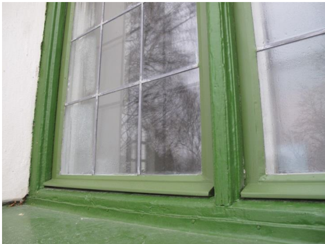
Fönster efter åtgärder. Skillnaden mellan linoljefärgen och alkydoljefärgen är tydlig.
